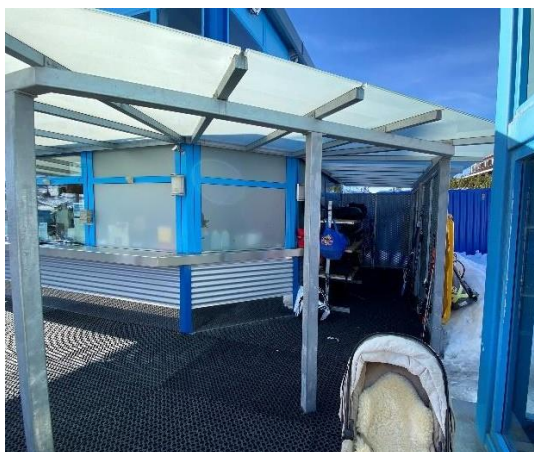
Deposito per sedie a rotelle
